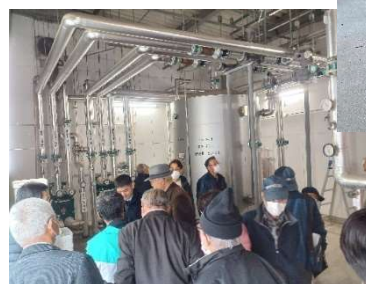
木次健康温泉センターのチップ用ボイラーを見学
